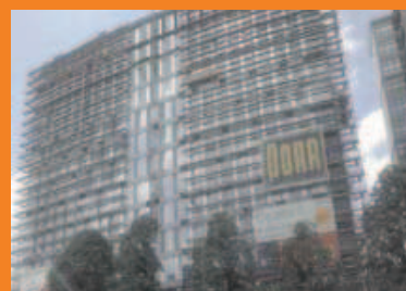
EQUATOR II - biurowiec w Warszawie (w budowie)
